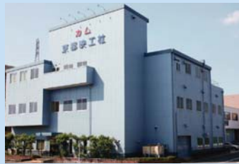
〈京都映工社社屋全景〉
