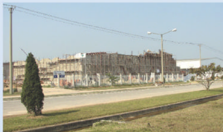
▲建設工事の様子
