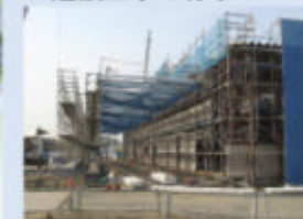
▼建設工事の様子
